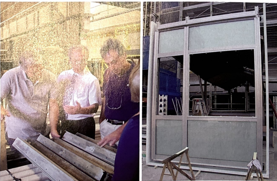
損傷を免れたアルミ枠などは洗浄し、オリジナルに忠実となるように再利用した
