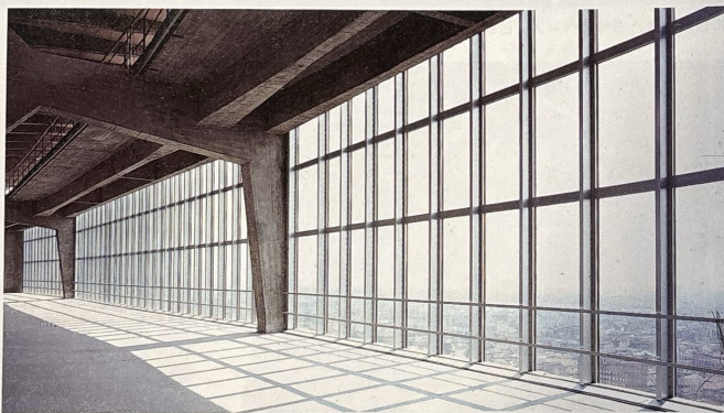
サルノ氏が手がけ、先に改修が終わっていた31階の展望ホール「ベレパペレ」。ミラノを一望にできる。建築の構造体の様子がよくわかるように、躯体をむき出しのままとしている
